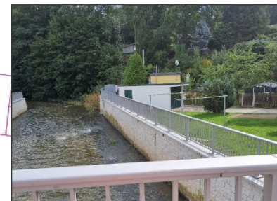
Blick von der Brücke Hedwigstraße nach unterstrom
