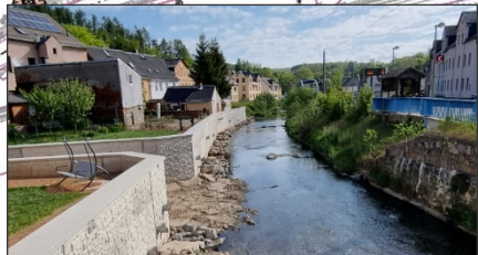
Blick von Brücke Friedrichstraße nach unterstrom
