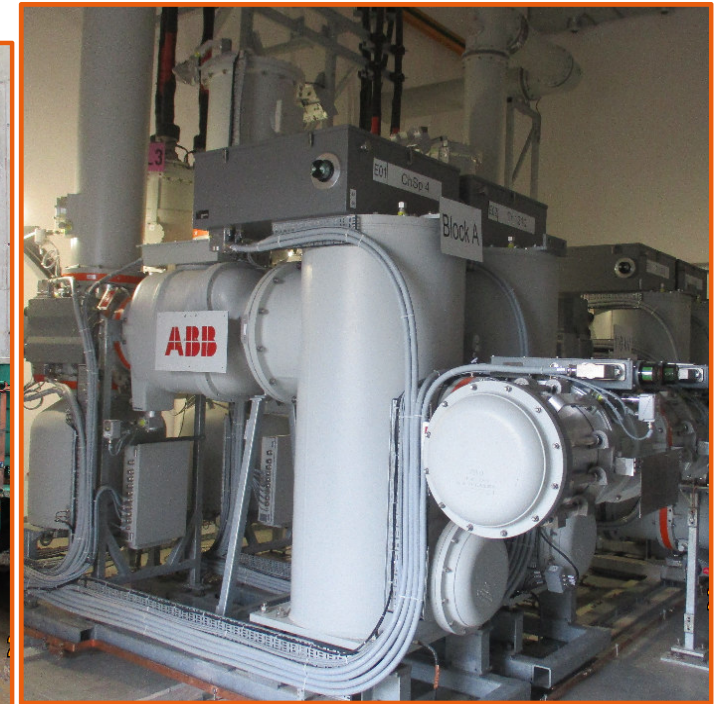
Fertigstellung 110-kV-Schaltanlage
