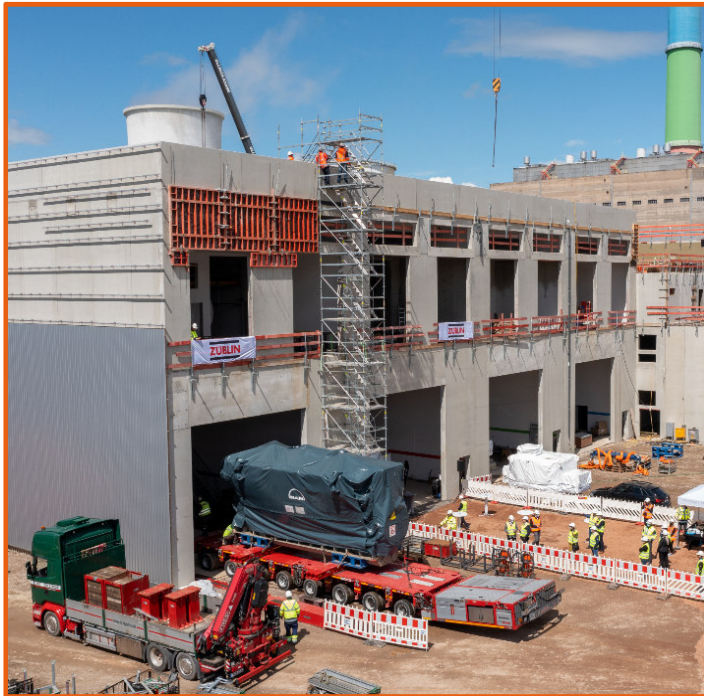
Einbringung letzter Motor
