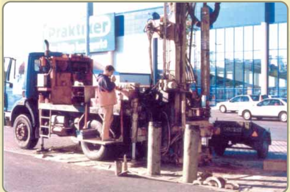
Abb. 23: Bohrarbeiten zur Errichtung von Grundwassermessstellen im Abstrombereich (Gewerbegebiet)
