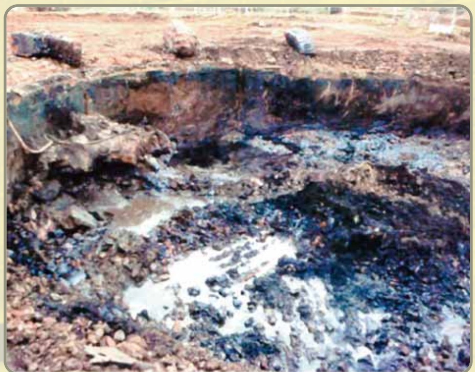
Abb. 19: Gasometer mit teerölkontaminiertem Bauschutt
