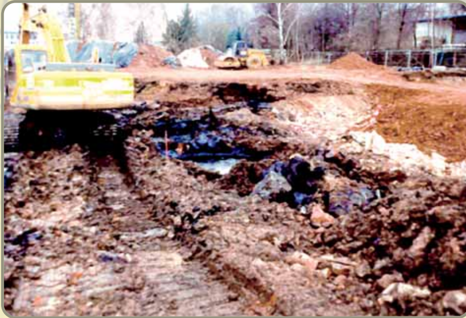
Abb. 20: Teergruben und Randbereich des wiederverfüllten Gasometers
