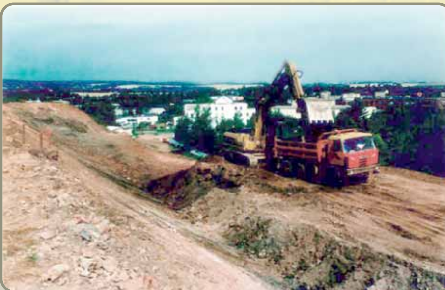
Abb. 24: Umlagerung von Deponat im Rahmen der Böschungskonturierung
