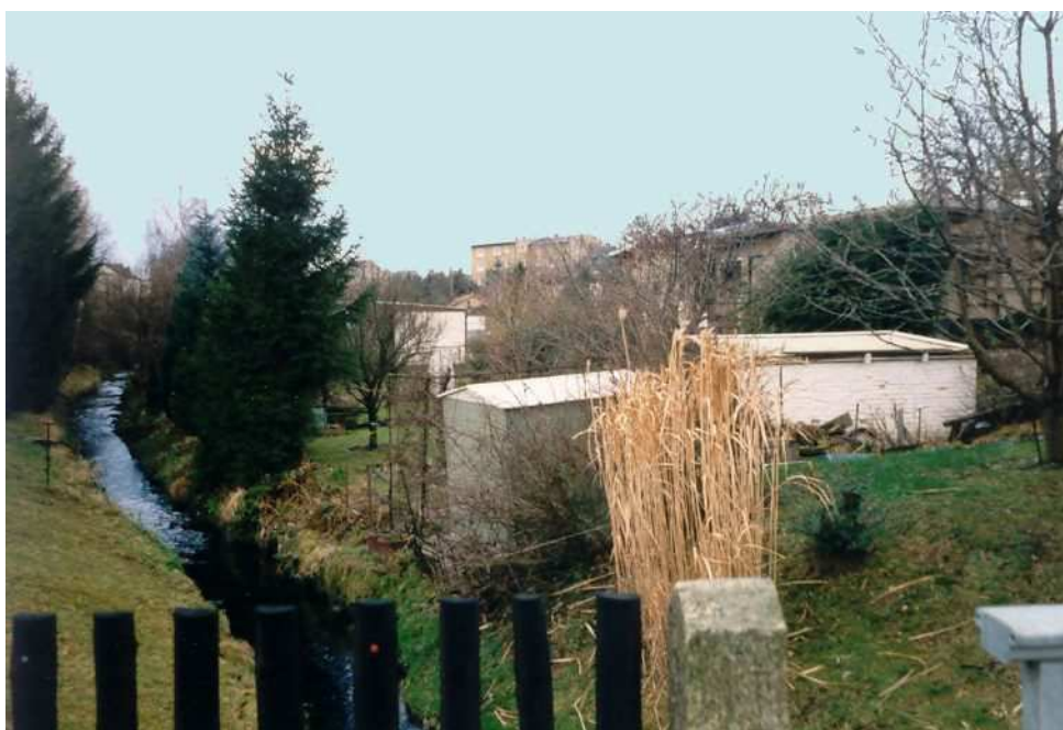
Bild 7: In diesen Kleingärten ist als vorbeugender Hochwasserschutz der Uferbereich von Baulichkeiten und Anpflanzungen freizuräumen
