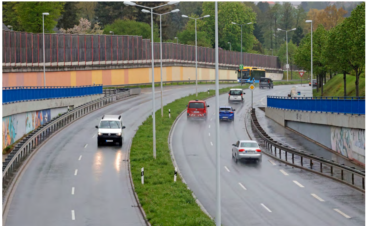
Der Abschnitt zwischen Zschopauer und Bernsdorfer Straße des Südrings wird in diesem Sommer saniert.
