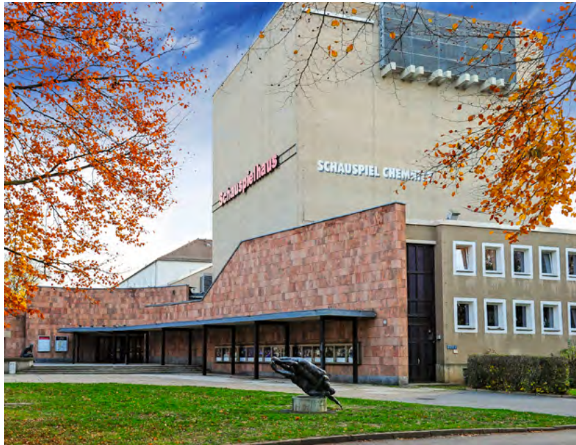
Die Sanierung des Schauspielhauses wird deutlich teurer als zunächst angenommen. Deshalb muss das Vorhaben neu bewertet werden. Foto: Nasser Hashemi
