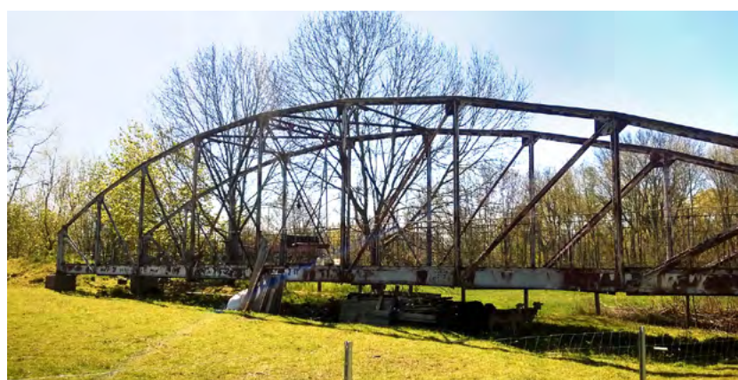
Die historische Fischwegbrücke wird umgesetzt und wird zu einem Teil des neuen Rastplatzes am Chemnitztal-Radweg. Foto: Stadt Chemnitz
